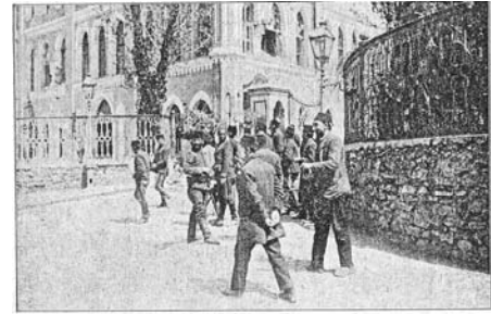
Taksim Kışlasında top atışlarından harab olmuş mahaller
