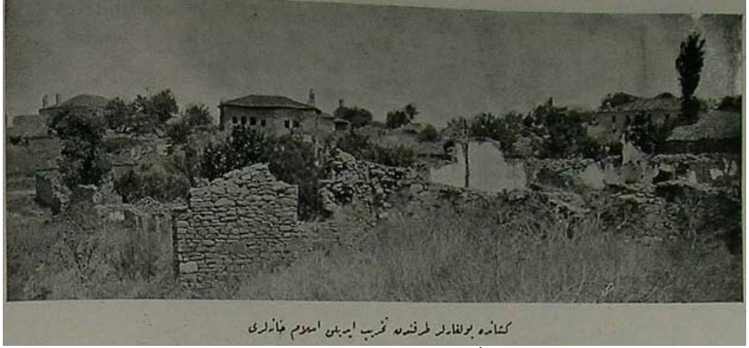
Keşanda Bulgarlar tarafından tahrîb edilen İslam mahallesi
