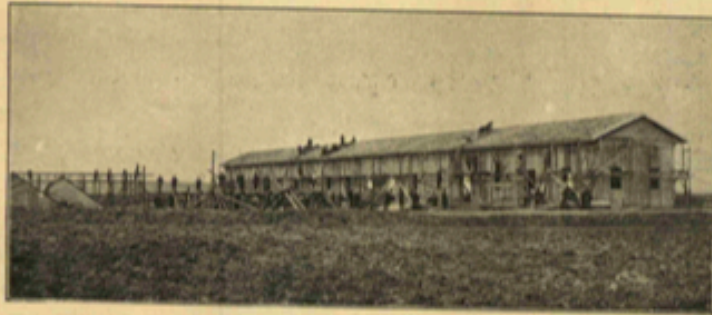
[ تکفور طاقندن مرادلی طرفایله حدود حانده سوق اولان جنود حانده ملوکانه صهرمت ایدان باراقه لار ] La Construction des baraquements Militaires à la station mouratly sur la ligne de Salonique
