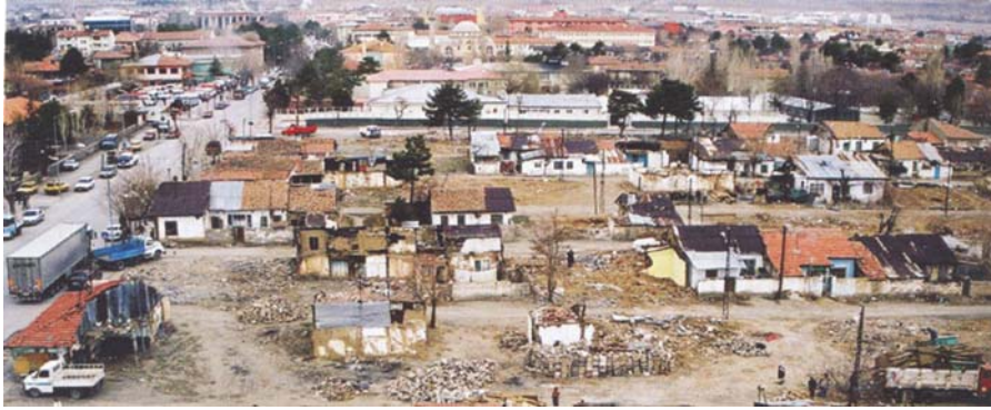
Fig. 10 Erzincan Çarşı Gecekondu Transformation Area before transformation
