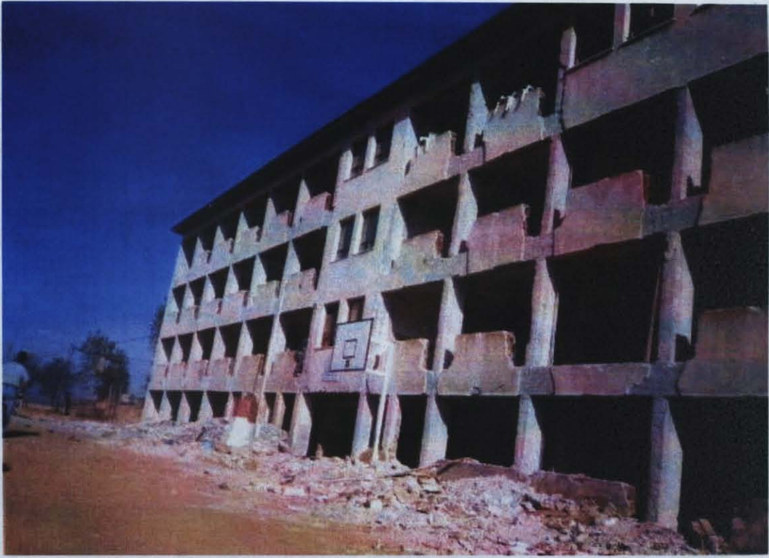
Photo D.21 – Retrofit of Maltepe Kaşgarlı Mahmut İ.Ö.O.
